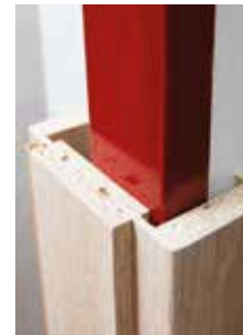
obklad ocelovej zárubne
